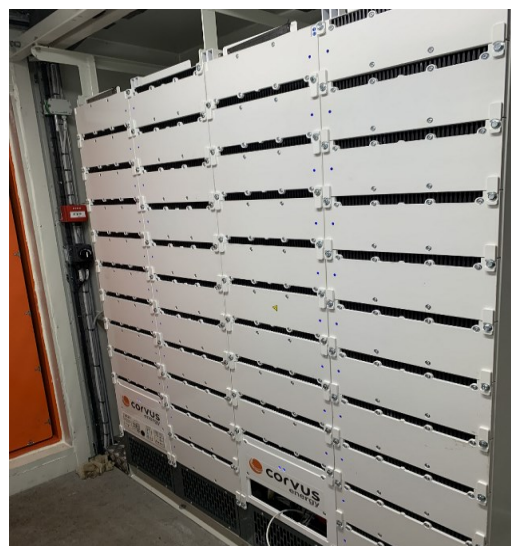
Рисунок 4 – Розташування АБ в контейнері
